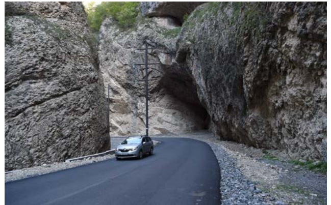
Une tronçon de la nouvelle route Vardenis-Martakert
