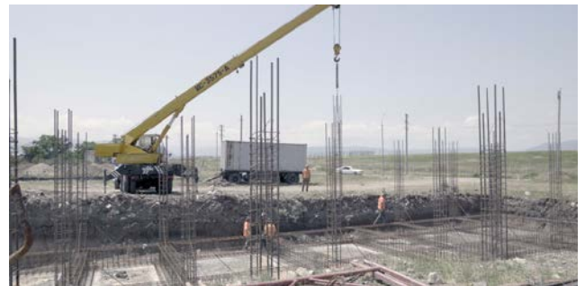
Construction d'un quartier résidentiel près de Ivanyan dans la région d'Askeran (Artsakh)
